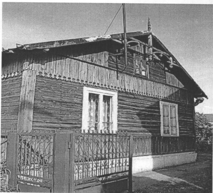
Domy wznoszono na podmurówce, ściany łączono na zrąb, szczyt zdożyły misternie powycinane deseczki oraz drewniany detal w formie spotykanej raczej na linii otwockiej. Wystająca ponad dach zaostrzona belka to tzw. wiatrownica.
