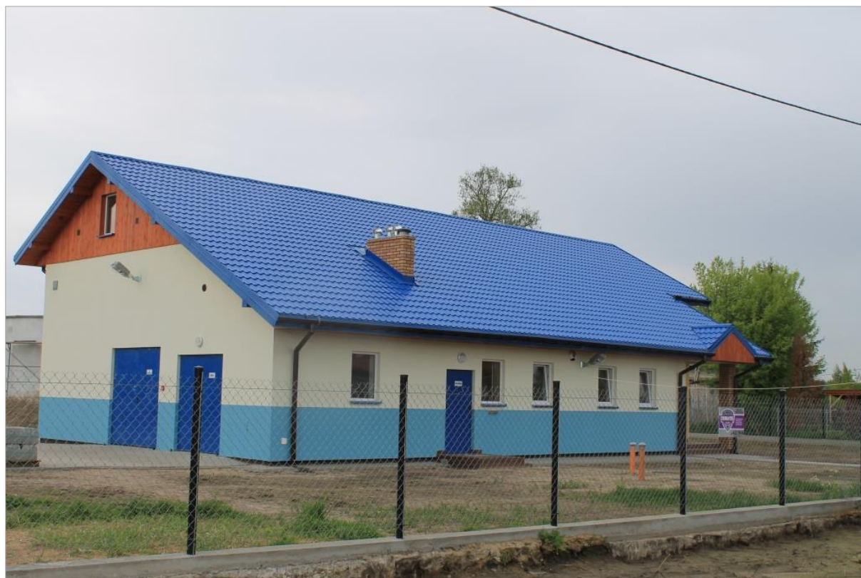
Zdjęcie 8. Stacja uzdatniania wody w Gminie Poświętne.
