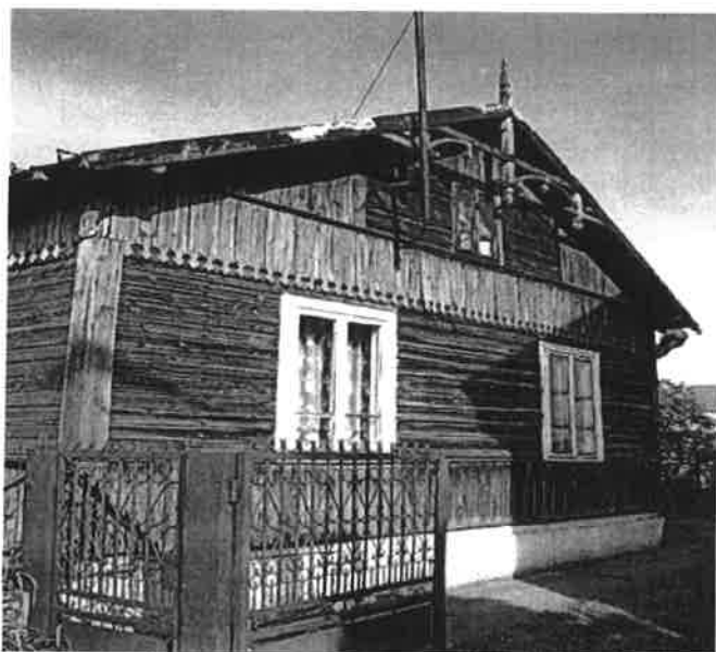
Domy wznoszono na podmurówce, ściany łączono na zrąb, szczyt zdobity misternie powycinane deseczki oraz drewniany detal w formie spotykanej raczej na linii otwockiej. Wystająca ponad dach zaostrożona belka to tzw. wiatrownica.
