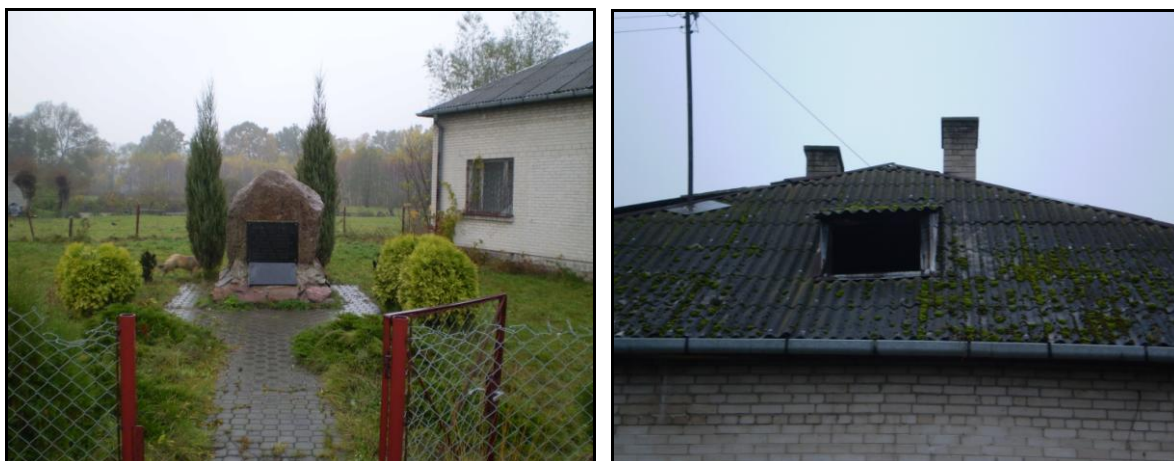
Fot. 12 - Widok budynku wraz z pomnikiem rodziny Lelewelów oraz widok starego azbestowego dachu
