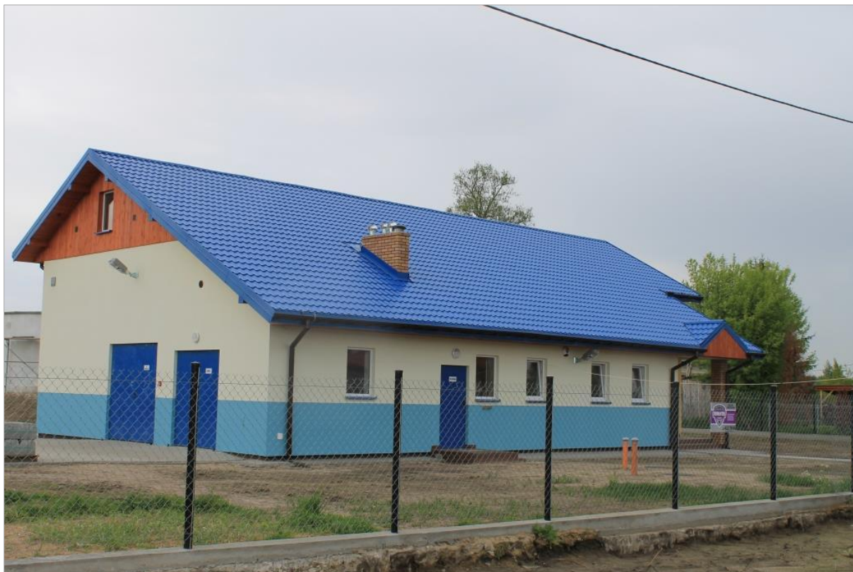
Zdjęcie 8. Stacja uzdatniania wody w Gminie Poświętne.
